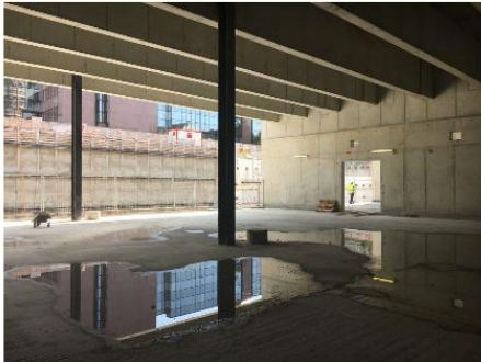
Der Ballsaal im Rohbau: 650 Personen sollen darin Platz finden.
