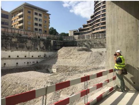
Hier stand einst das Hilton. Blick auf eines der Baufelder.
