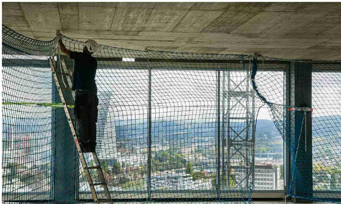
Hoch hinaus. Mit dem Bau des Baloise Parks verdoppelt die Versicherung die Nutzfläche am Aeschengraben durch Verdichtung nach oben auf rund 100 000 Quadratmeter. Foto Nicole Pent
