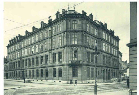
1867 bezogen. Verwaltungsgebäude an der Elisabethenstrasse.
