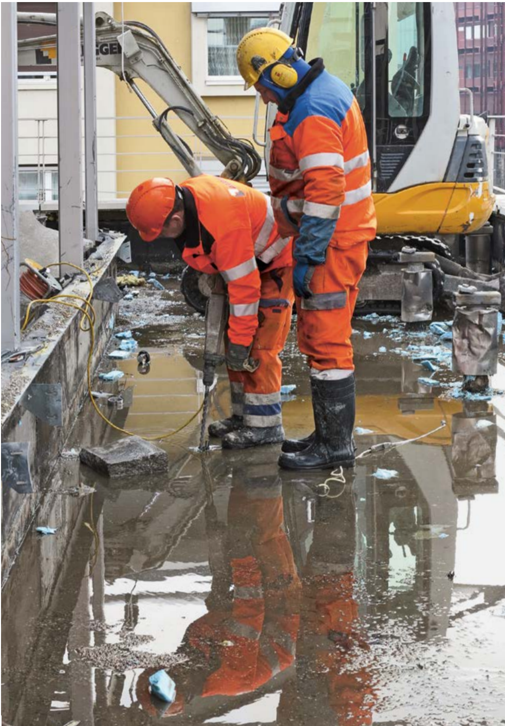
Umgekehrter Vorgang eines Hochbaus: Alle Einbauten wie sanitäre Anlagen, Heizungen, Lüftungskanäle, die gesamte Elektrik, die Isolation und die Fenster werden entfernt, bevor die Bagger Wände und Decken abtragen können.
